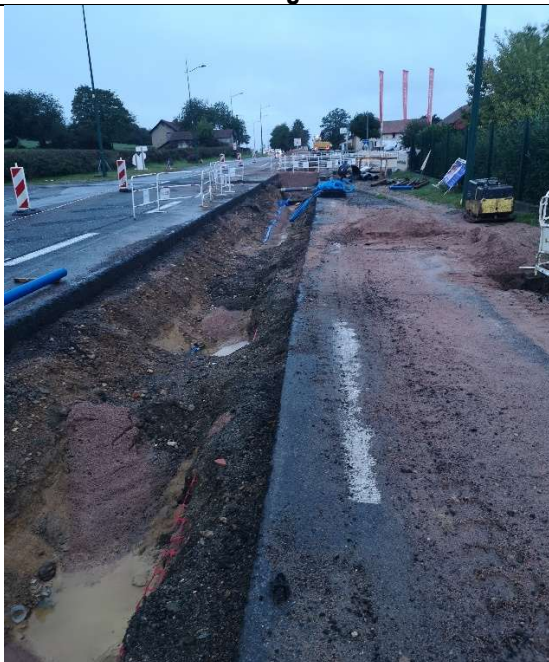
LAPALISSE « Avenue du 8 mai 1945 » Remplacement de 212 ml de conduite PVC diamètre 110 mm de 1974 Par conduite fonte diamètre 100 mm Renouvellement de 4 branchements (+ création d'un branchement)
