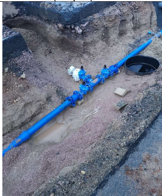
LAPALISSE « Avenue du 8 mai 1945 » Remplacement de 212 ml de conduite PVC diamètre 110 mm de 1974 Par conduite fonte diamètre 100 mm Renouvellement de 4 branchements (+ création d'un branchement)
