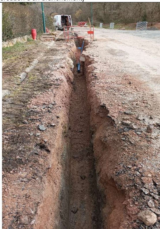
ARFEUILLES « La Boulère » Remplacement de 1 284 ml de conduite PVC 90 mm posés en 1982 Pose de 1100 ml de conduite fonte 100 mm Reprise de 48 branchements Travaux commencés fin 2025 et qui seront terminés à la fin du 1er trimestre 2026
