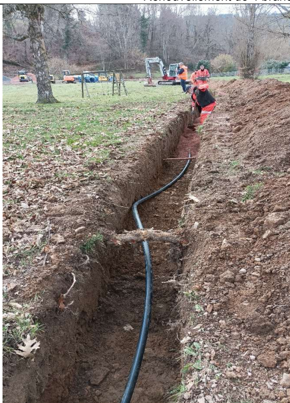
ARFEUILLES « La Boulère » Remplacement de 1 284 ml de conduite PVC 90 mm posés en 1982 Pose de 1100 ml de conduite fonte 100 mm Reprise de 48 branchements Travaux commencés fin 2025 et qui seront terminés à la fin du 1er trimestre 2026
