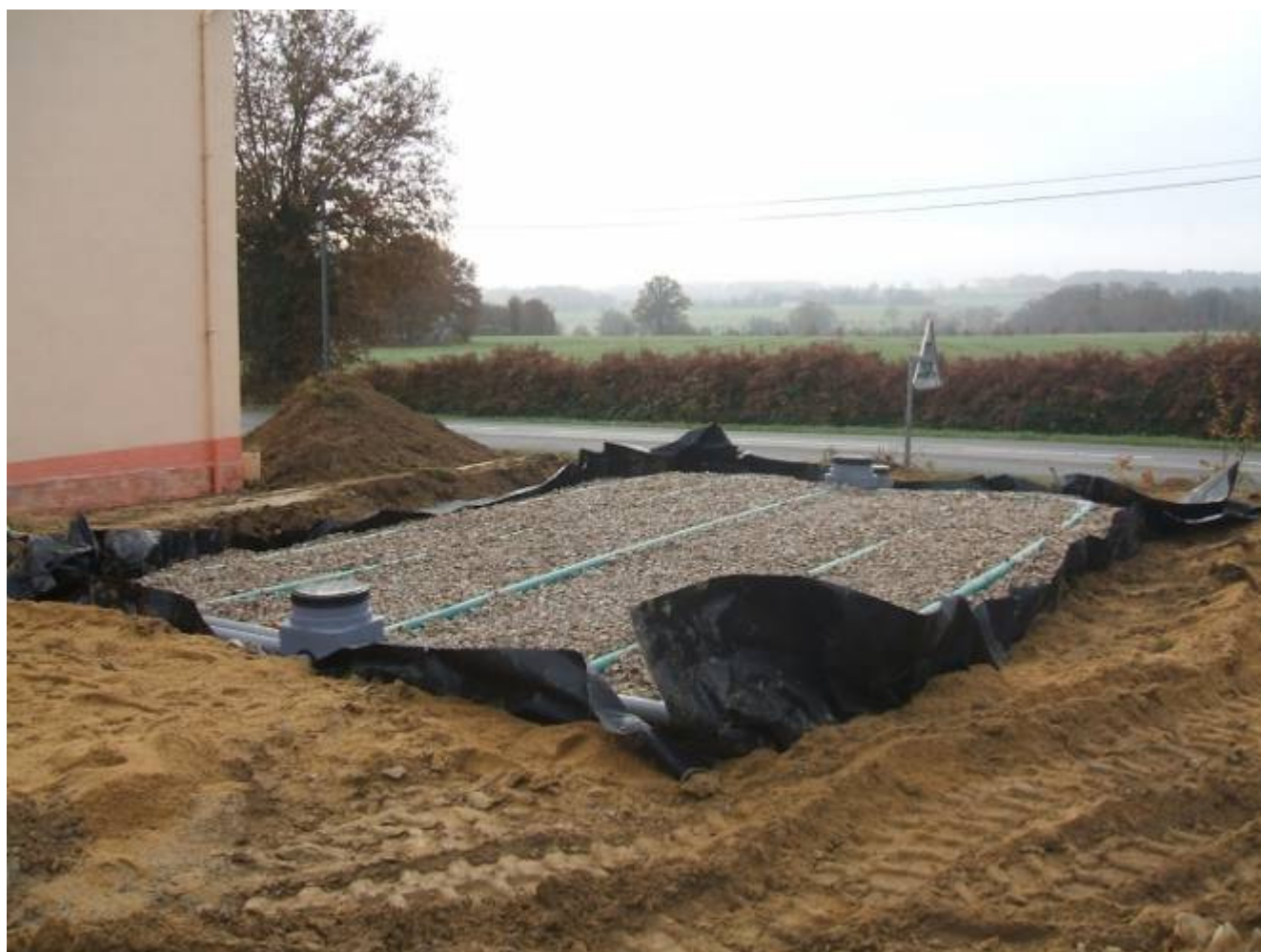
Filtre à sable vertical drainé
